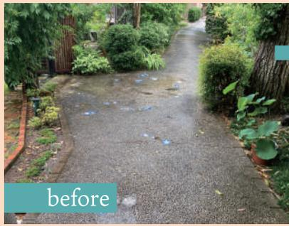
洗い出しのアプローチは古くなるとポロポロめくれてきます。コンクリートにスタンプを押す「ローラストーン工法」なら価格も時間も節約できます。
